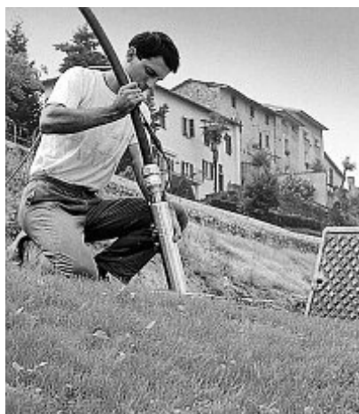
Rys. 26. Opuszczanie pompy do studni [14]
