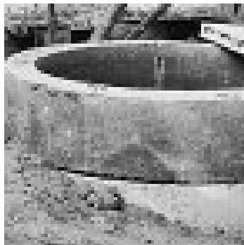
Rys. 12. Kręgi betonowe w studni kopanej [14]
