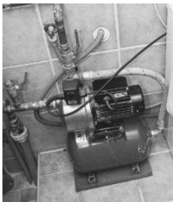
Rys. 41. Połączenie hydrofor z instalacją – widok [14]
