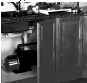
Rys. 39. Usytuowanie hydroforu pod zlewozmywakiem [14]
