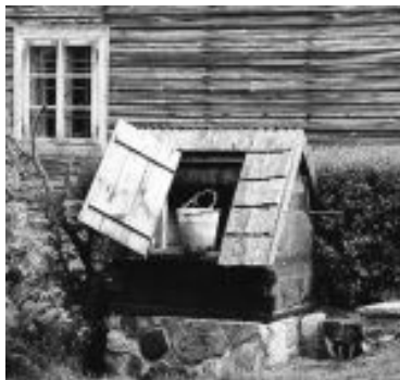
Rys. 8. Widok studni kopanej [12]
