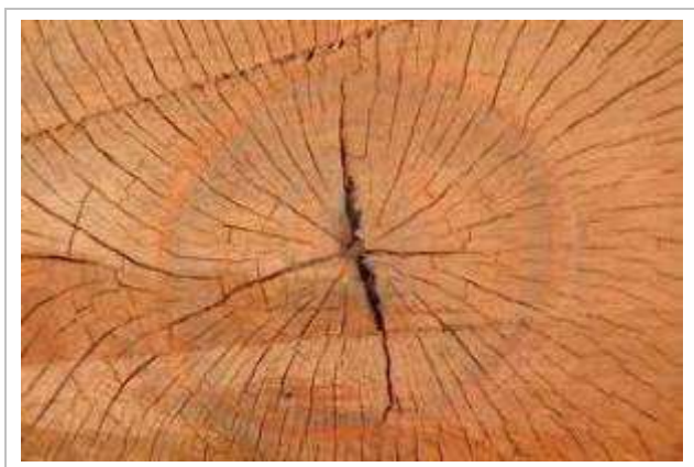
Rysunek 3.4 Pęknięcia rdzeniowe proste
