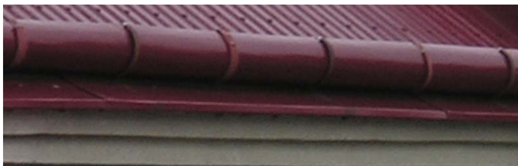
Rys. 10. Obróbka blacharska okapu. [zdj. aut.]
