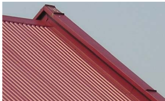
Rys. 12. Obróbka blacharska kalenicy i ścian szczytowych widziana od strony a) ściany, b) połaci dachowej [zdj. aut.]
