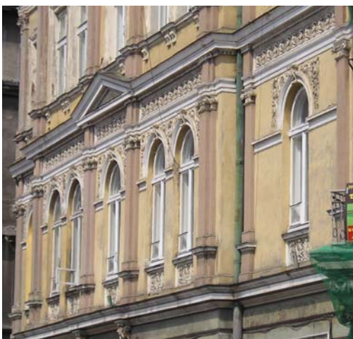
Rys. 5. Gzysy a) międzykondygnacyjne, b) nadotworowe. [zdj. aut.]
