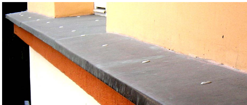
Rys. 7. Gzyms podokienny ciągły. [zdj. aut.]
