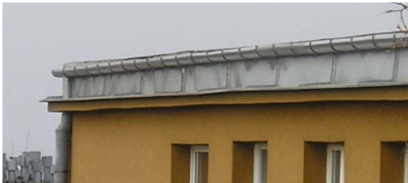
Rys. 4. Gzys podrynnowy. [zdj. aut.]
