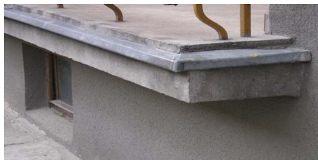
Rys. 8. Płyta balkonowa. [zdj. aut.]
