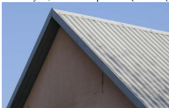
Rys. 13. Obróbka blacharska kalenicy i krawędzi szczytowych. [zdj. aut.]
