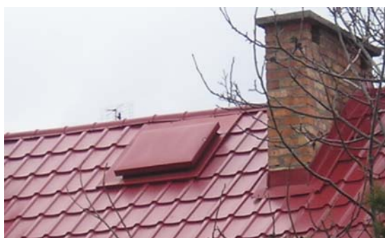
Rys. 16. Właz dachowy. [zdj. aut.]
