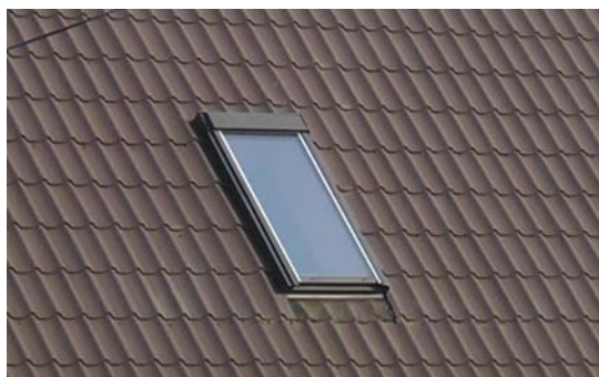
Rys. 17. Okno dachowe. [zdj. aut.]
