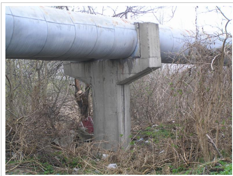
Rysunek 5.2 Podpory stałe
