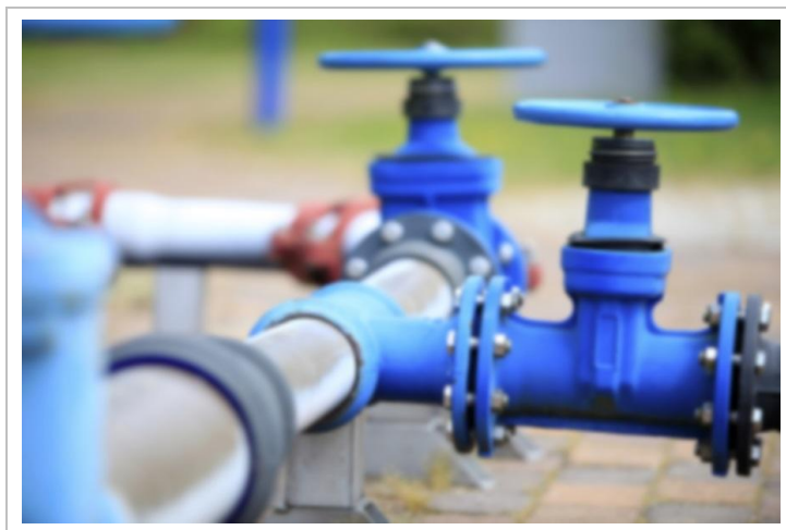
Rysunek 5.5 Zawory odwadniające i odpowietrzające
