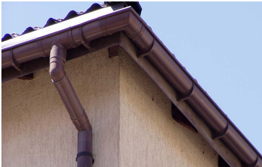
Rys. 1. Ryzna wisząca półokrągła zamocowana do deski okapowej z lejem włożonym do rury spustowej [opracowanie własne]
