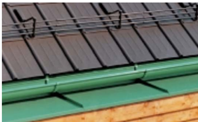
Rys. 50. Pas podrynnowy i zabezpieczenie rynny przed zsuwającym się śniegiem [folder producenta]
