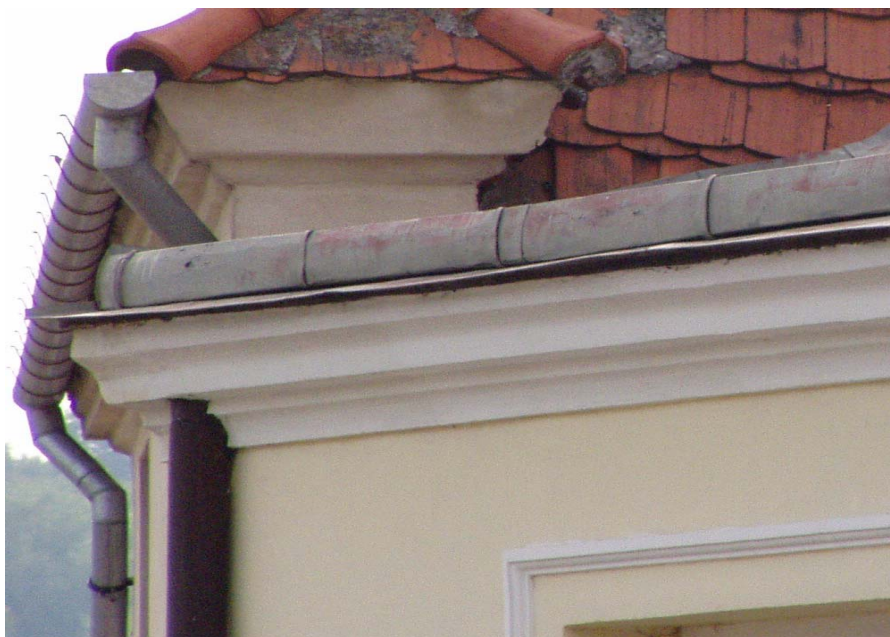
Rys. 3. Rynna stojąca z rurą spustową przechodzącą przez gzyms i rynna wisząca półokrągła [opracowanie własne]
