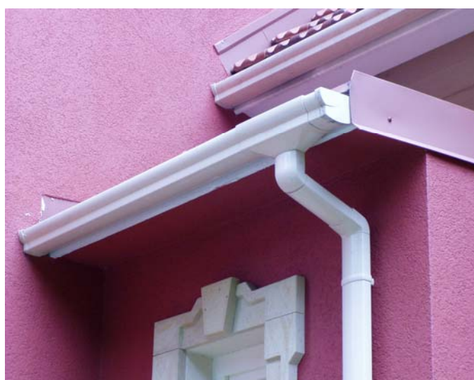
Rys. 6. Rynna wisząca prostokątna, z rurą prostokątną [opracowanie własne]
