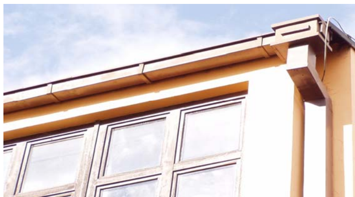
Rys. 6. Rynna wisząca prostokątna, z rurą prostokątną [opracowanie własne]
