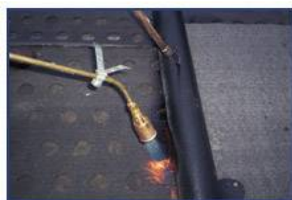
Rys. 76. Montaż papy termozgrzewalnej – zdjęcie [opracowanie własne].
