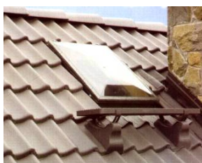
Rys. 51. Zamontowany wyłaz standardowy – zdjęcie [6, s. 135]. Rys. 52. Wyłaz standardowy – zdjęcie [6, s. 140].
