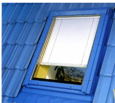
Rys. 8. Oblachowanie okna z blachy aluminiowej w kolorze pokrycia dachowego – zdjęcie [6, s. 42].
