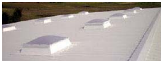
Rys. 44. Świetlik punktowy- zdjęcie [opracowanie własne].
