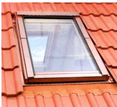
Rys. 6. Oblachowanie okna z blachy miedzianej – zdjęcie [6, s. 41].
