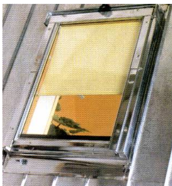
Rys. 7. Oblachowanie okna z blachy cynkowo – tytanowej - zdjęcie [6, s. 41].
