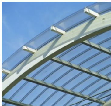
Rys. 6. Zadaszenie z płyt poliwęglanowych Icopal [www.icopal.pl]
