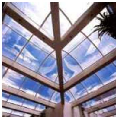
Rys. 5. Zadaszenia z płyt poliwęglanowych robelit [www.robelit.pl]
