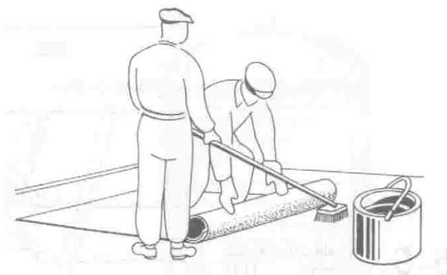
Rys. 29. Przyklejanie papy do podkładu betonowego [9, s. 134]
