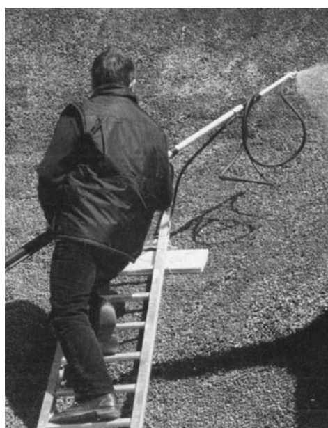
Rys. 1. Impregnowanie trzciny [17, s. 86]
