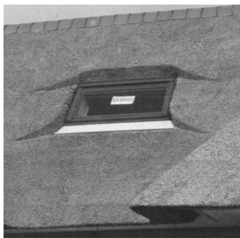
Rys. 4. Okno połaciowe w dachu z trzciny [16, s.133]
