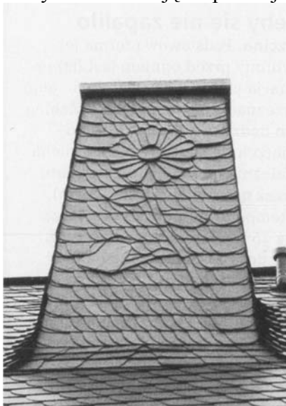
Rys. 27. Łupkiem można wykończyć także ścianki komina [17, s.91]
