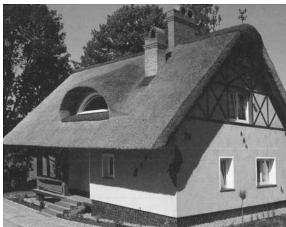
Rys. 3. Połacie dachu krytego słomą z oknem typu wół oczko, jednym kominem w kalenicy dachu, drugim kominem w połaci dachowej [17, s. 84]
