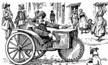
Rys. 0.1. Trójkołowy pojazd napędzany ręcznie za pomocą przekładni zębatej zbudowany w 1680 roku przez częściowo sparaliżowanego niemieckiego zegarmistrza Farflera [21]
