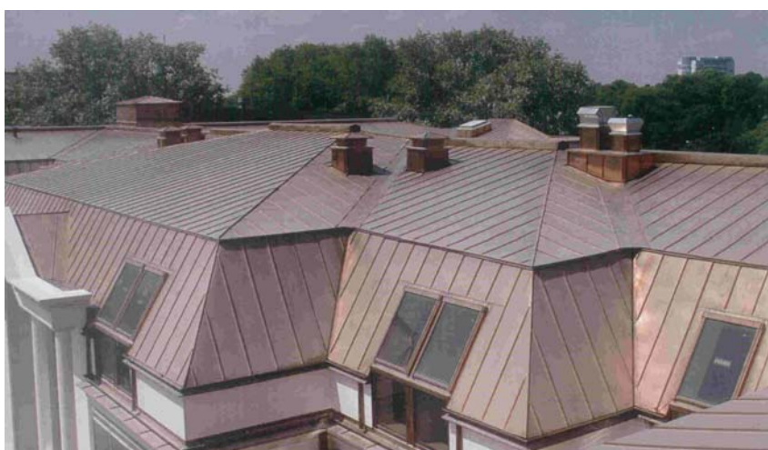
Rys. 13. Pokrycie dachowe wykonane z blachy miedzianej [16, s. 97]
