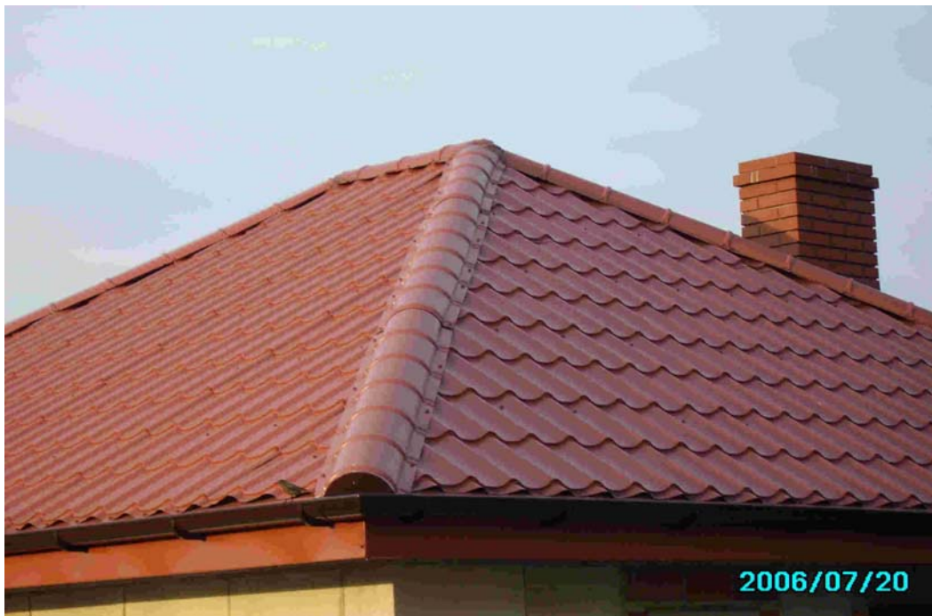
Rys. 21. Dach z blachy dachówkowej powlekanej [opracowanie własne]
